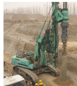
京石客运专线石家庄施工现场
