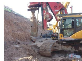
锥底旋挖斗施工现场
